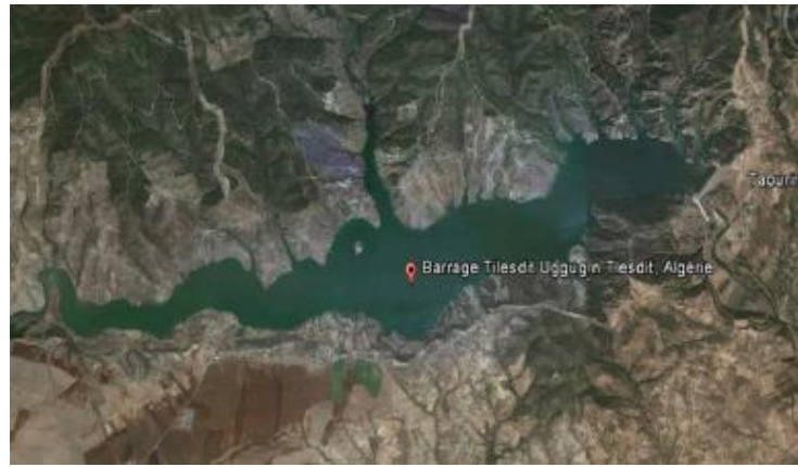
Fig .III.9. Image représentant le site du barrage « Tiledit » [Google Earth].
