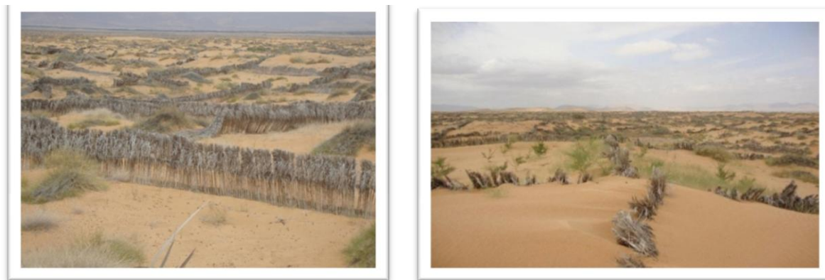
Figure 20 : Installation des palissades en palmier sèches (fixation mécanique)
