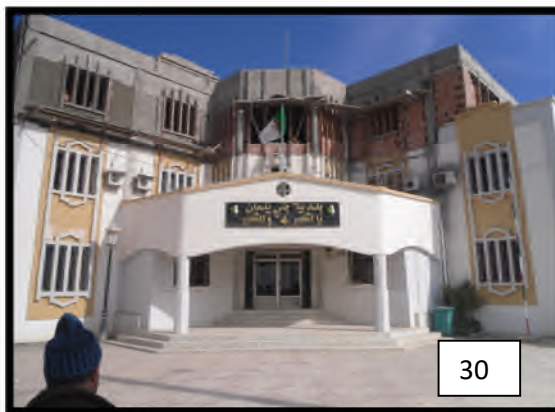
Siege de l'apc extention en hauteur
