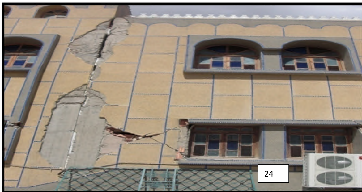
Photos N° 22 : dilatation des joints source CTC Msila
