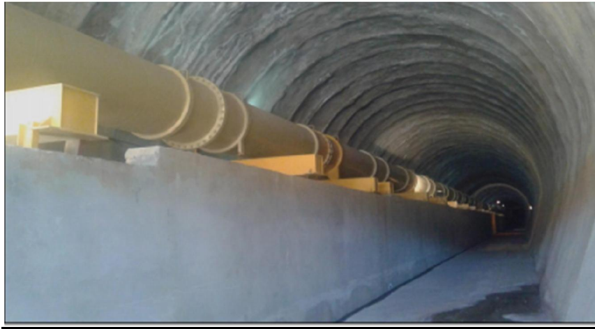
Fig n° II.13 : Tunnel de la vidange de fond
