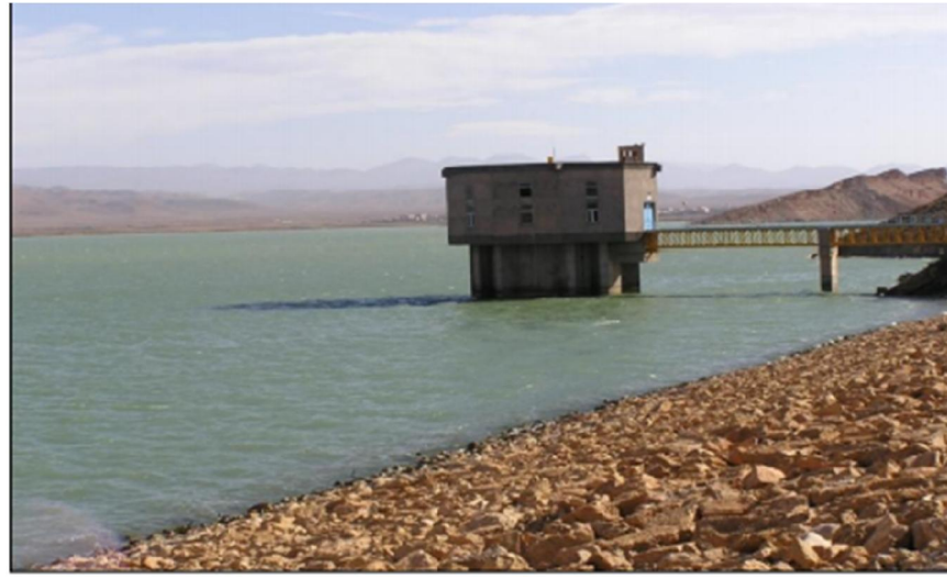
Fig n° II.14 : La tour de prise d'eau
