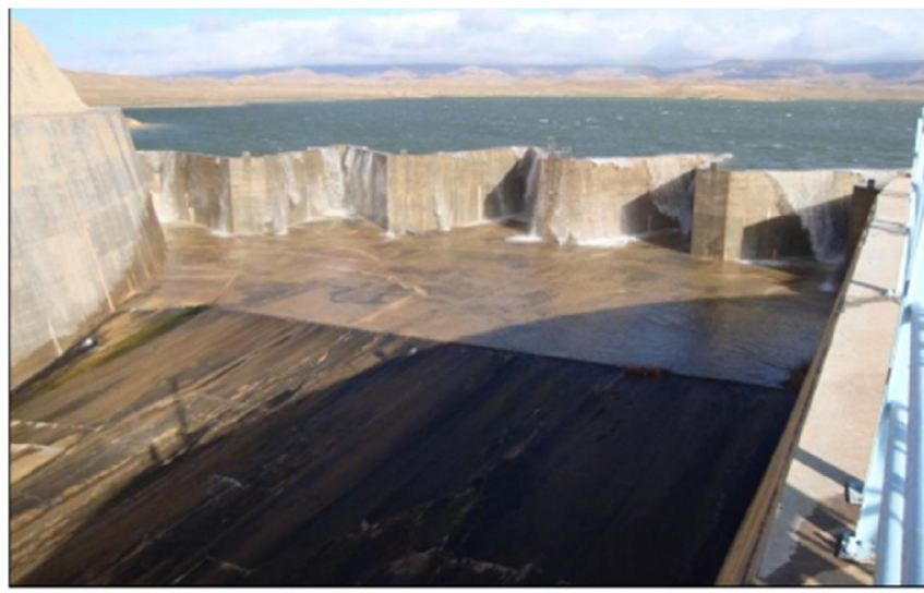
Fig n° II.12 : L'évacuateur de crue (ANBT, 2004)
