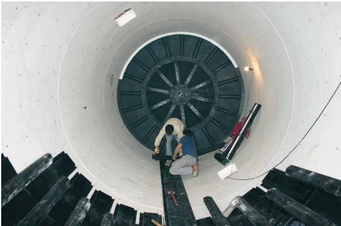
Figure IV.6 : Montage et assemblage de revêtement en caoutchouc dans broyeur à boulet [25].
