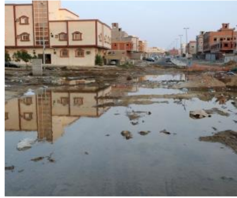
صورة رقم 11: طريق متضرر من المياه الجوفية
