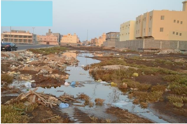
صورة رقم 12: صعود مياه داخل شوارع حي أجاويد بجدة
