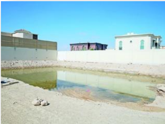
صورة رقم 04: ظهور المياه الجوفية على بعد متر خلال حفر الأساس في العين
