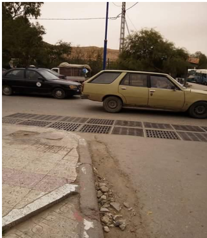
صورة رقم17: بالوعات مياه الأمطار
