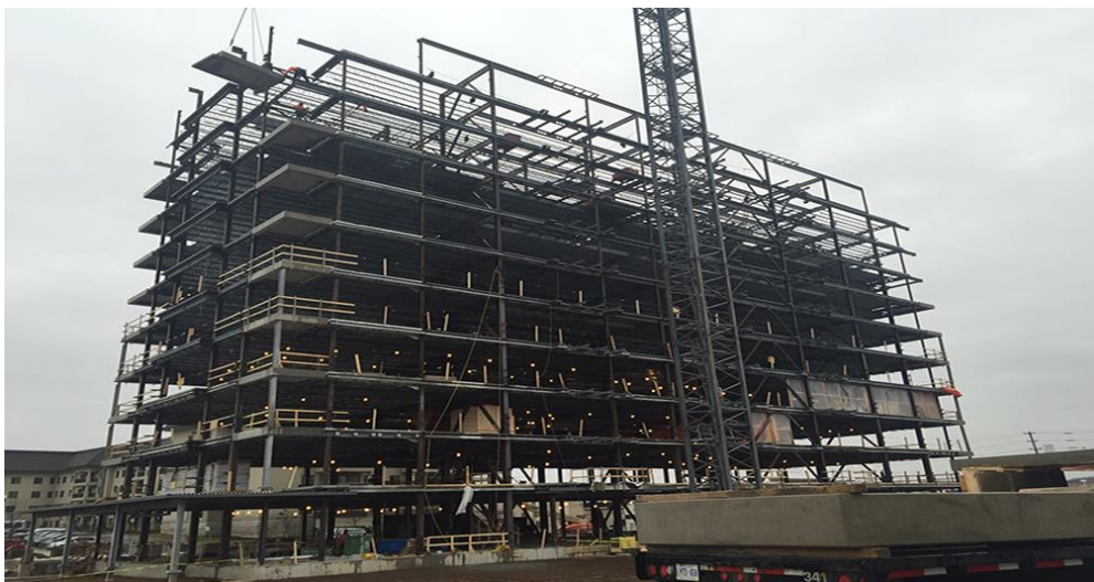
Figure 1.6. Structure en acier.
