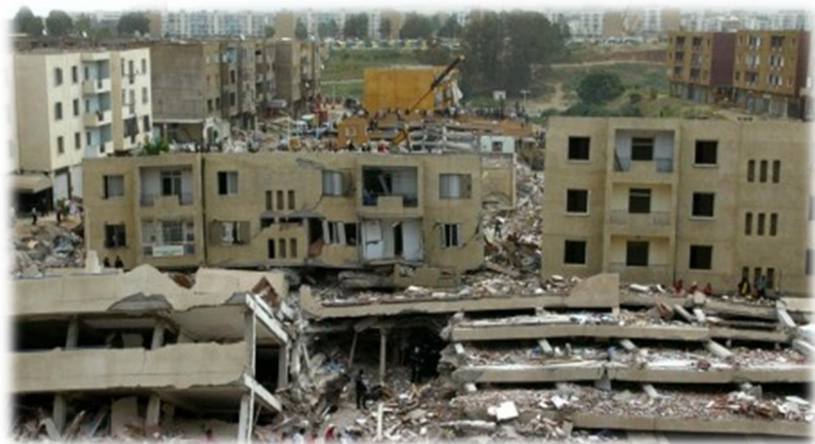
Figure 1.2. Dégâts de séisme de Boumerdès, 21 Mai 2003.
