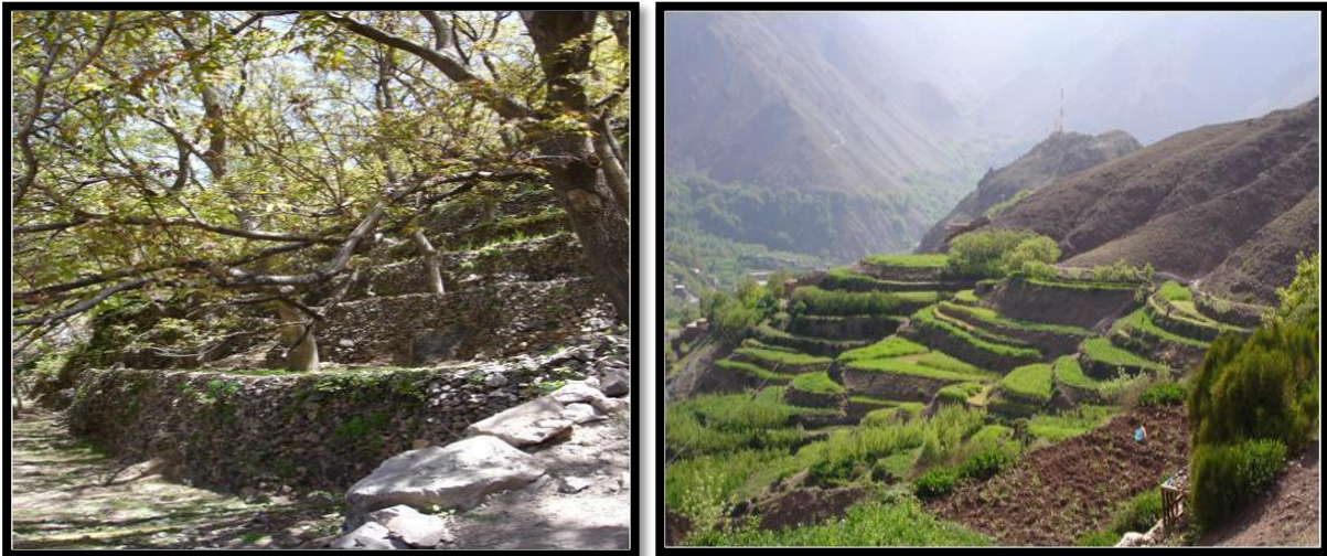
Figure VII .1 Une vue de versants aménagés par des terrasses soutenues par a-des talus et par b-des murs en pierre.
