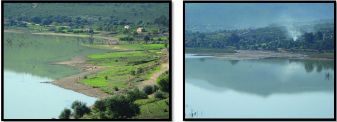
Figure V.5 Dépôts de vase dans le barrage sur la rive gauche (photo à gauche) et dépôts de vase à l'entrée de l'Oued Bougous au barrage (photo à droite) (Tourki, 2010)
