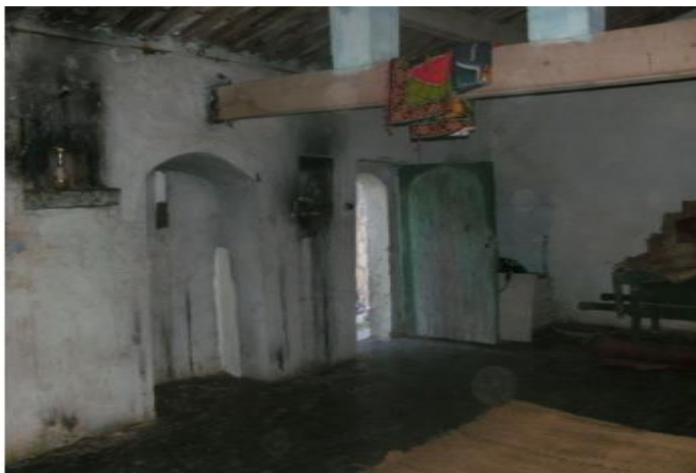
الملحق رقم 5: مسجد سيدي المهدي
