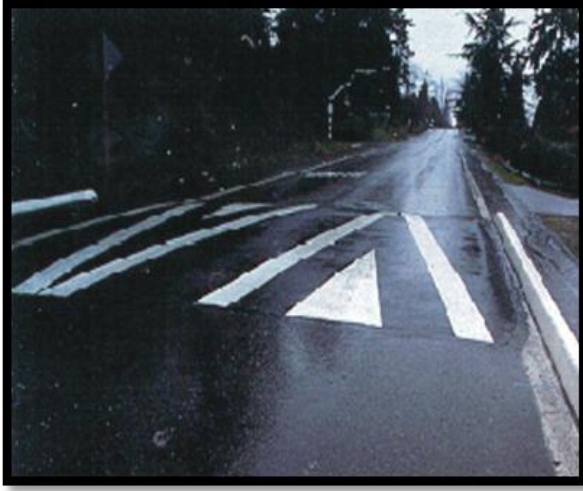
الصورة رقم (13): ممهل انسيابي.
