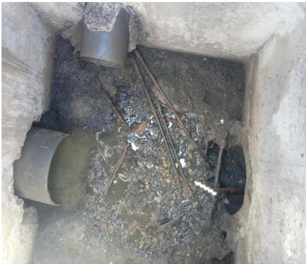
Figure III.1: Envasement des regards du réseau récemment réalisé en PVC
