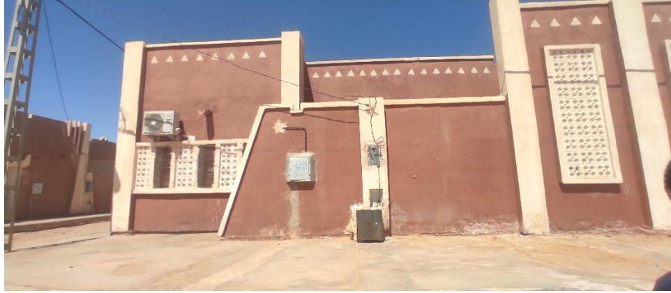
الصورة (15): الواجهة الشرقية للمسكن
