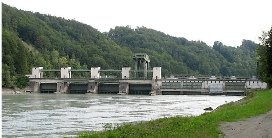
Figure I.7 : Photo d'une centrale hydroélectrique en Allemagne.
