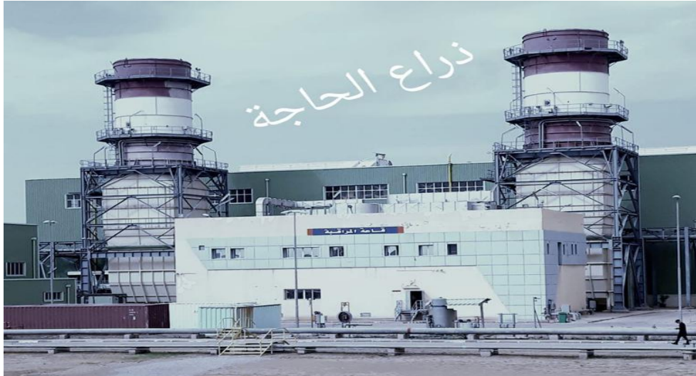
Figure III.2 : La société algérienne de la production d'électricité SPE, Draa El hadja à M'sila.
