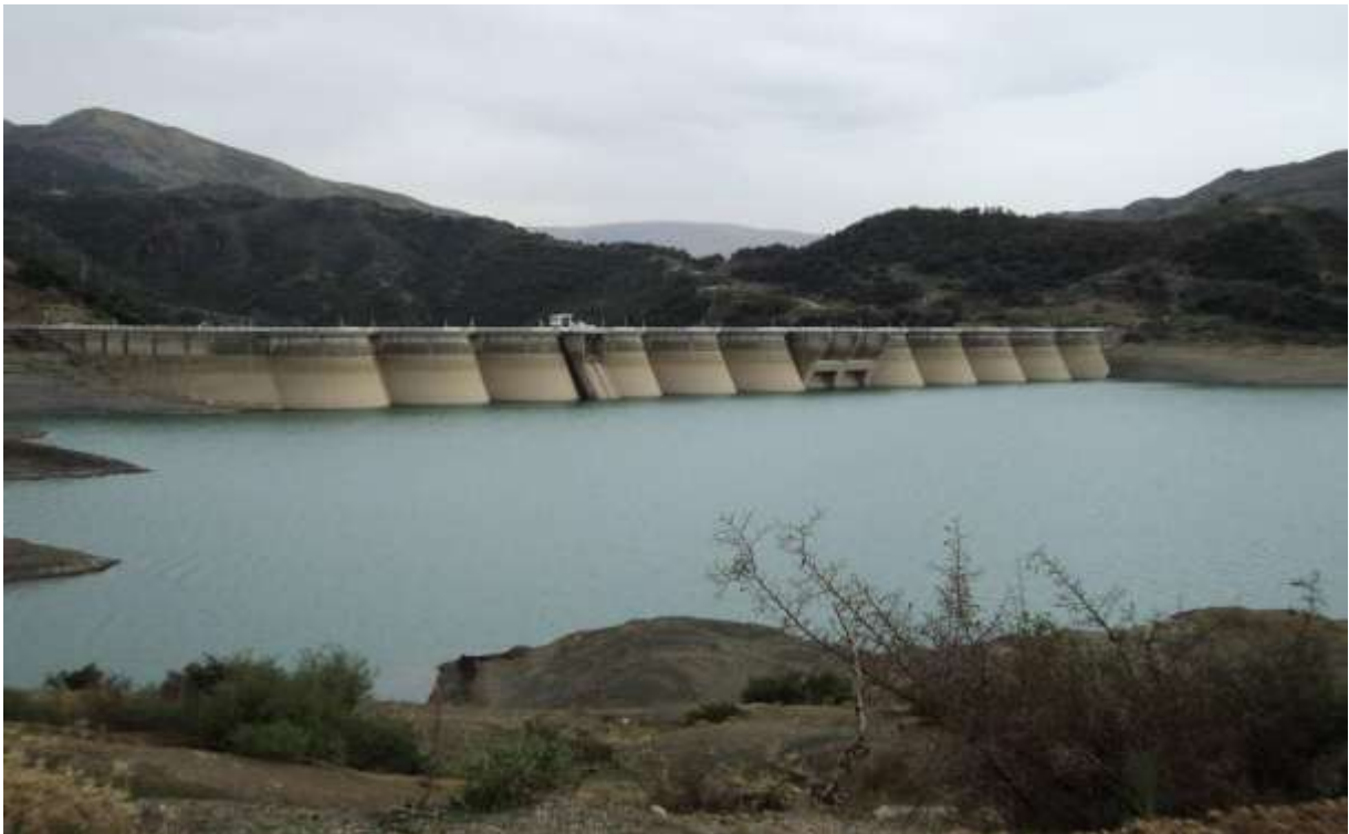
Figure I.5 Barrage à contrefort (barrage Erraguene Jijel-Algérie)
