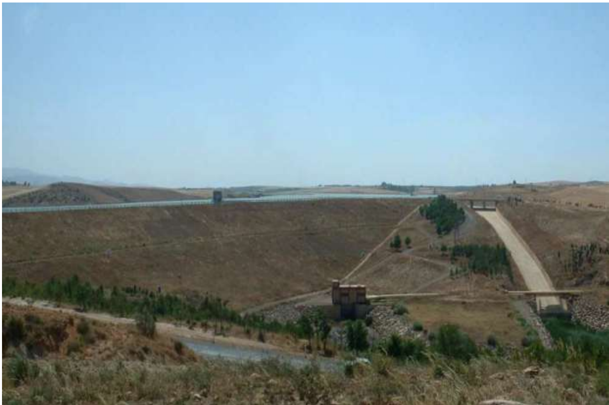
Figure I.14 Barrage zoné (Barrage Lekhal Bouira -Algérie)
