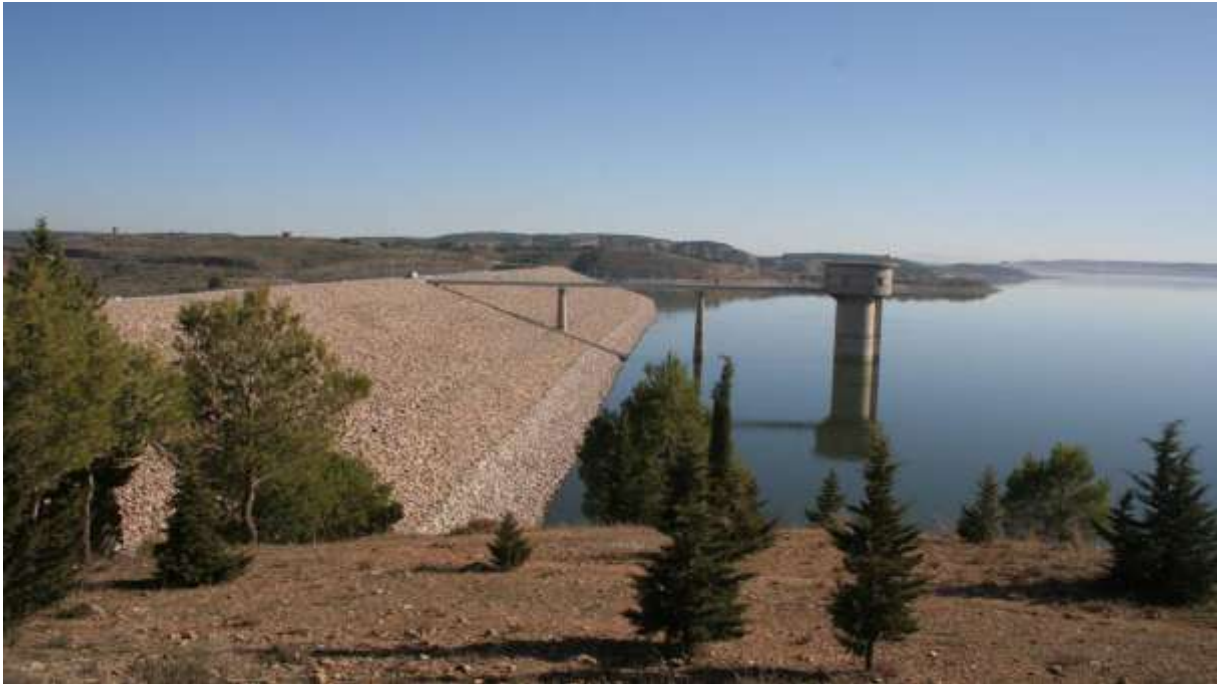
Figure II.4 Photo du barrage Ain Zada (Source ANBT)
