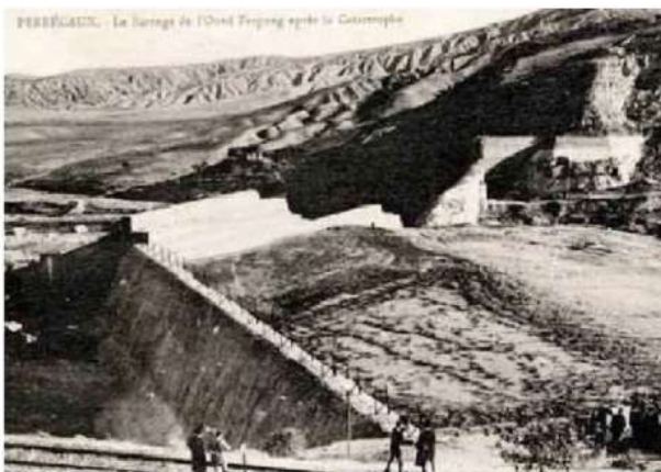
Figure I.15 Barrage de Fergoug après première rupture en 1881.
