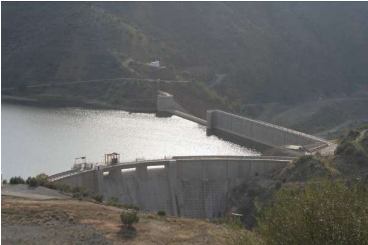
Figure I.7 Barrage-voûte (Barrage Tichy Haf Bejaia -Algérie)
