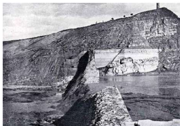
Figure I.16 Le barrage de Fergoug après deuxième rupture en 1927
