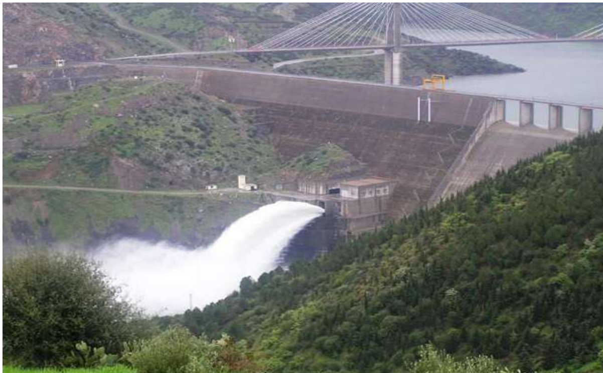
Figure I.3 Barrage-poids ( Barrage Béni Haroun Mila-Algérie)
