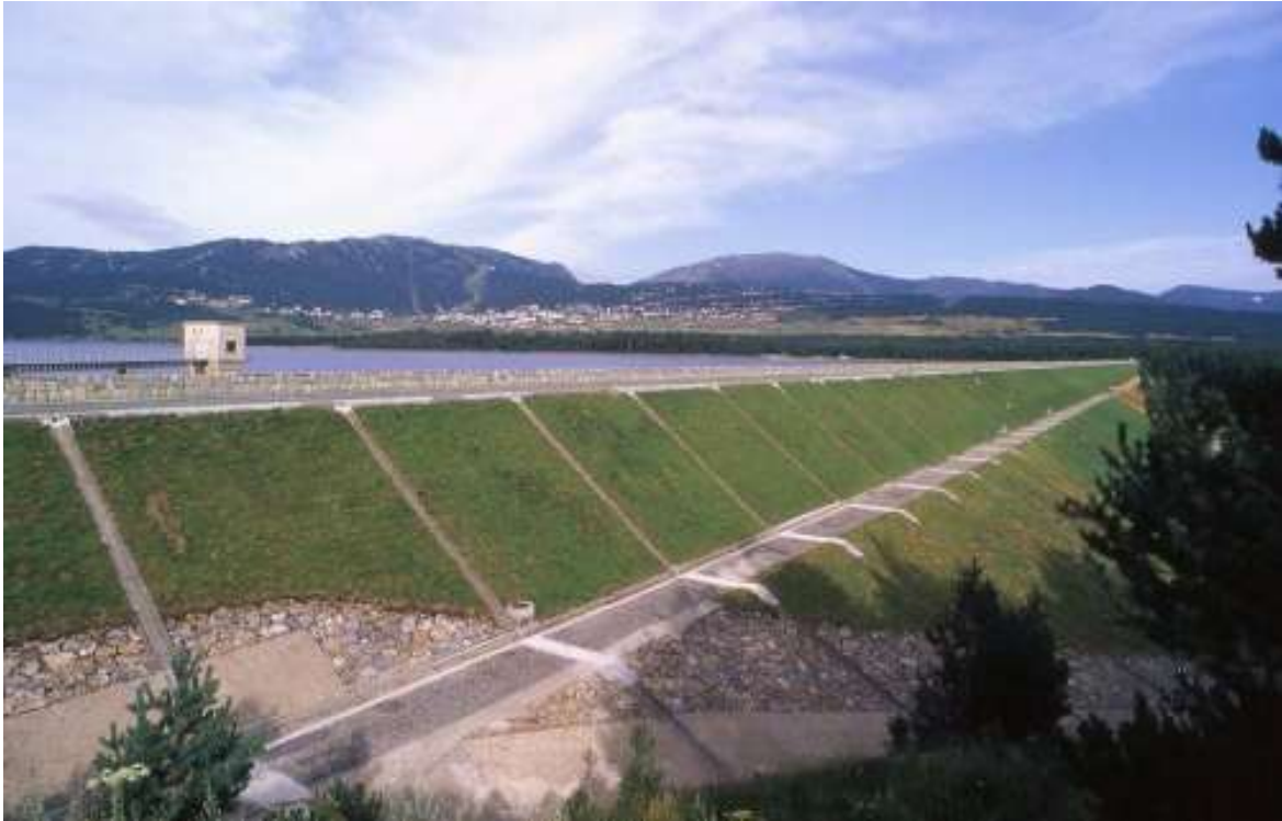
Figure I.12 Barrage homogène (Barrage Matemale-France)
