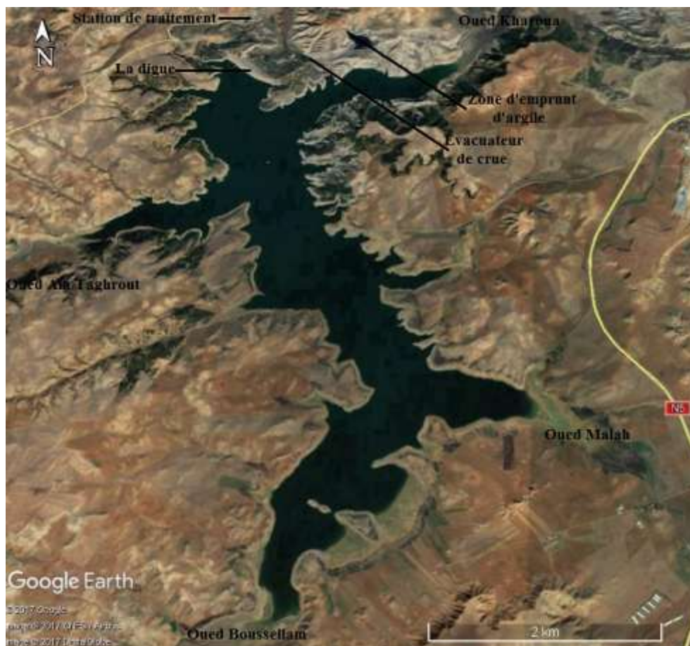
Figure II.1 Barrage Ain Zada wilaya de Bordj Bou Arreridj, Algérie (Photo Satellitaire 2017)
