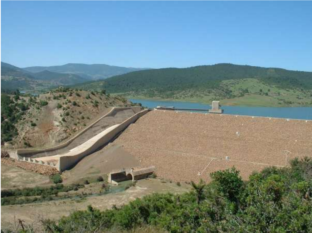
Figure I.10 Barrage en enrochement (Barrage Deurdeur d'Aïn Defla-Algérie)
