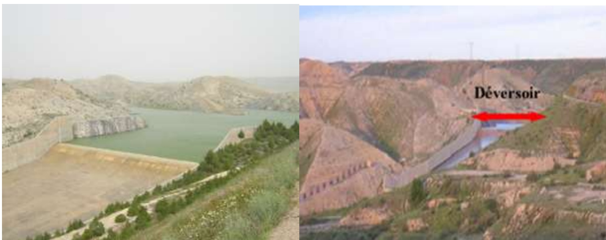
Figure II.6 Photos de l'évacuateur de crue (Source ANBT)
