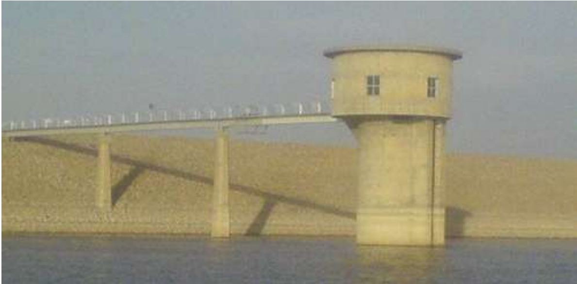
Figure II.9 Photo de la tour de prise du barrage Ain Zada (Source ANBT)
