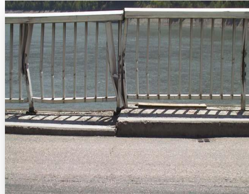
b) Exhaussement des bordures de crête sur le barrage du Chambon .
