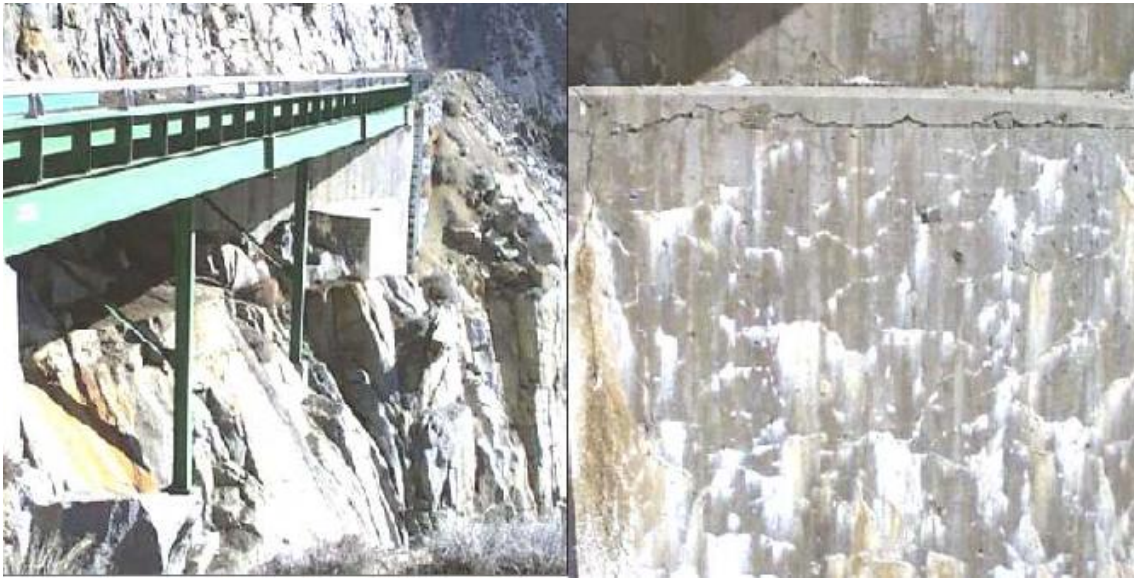
Figure I -8: Des cas pathologiques d'éléments en béton en contact de sulfate. [23]
