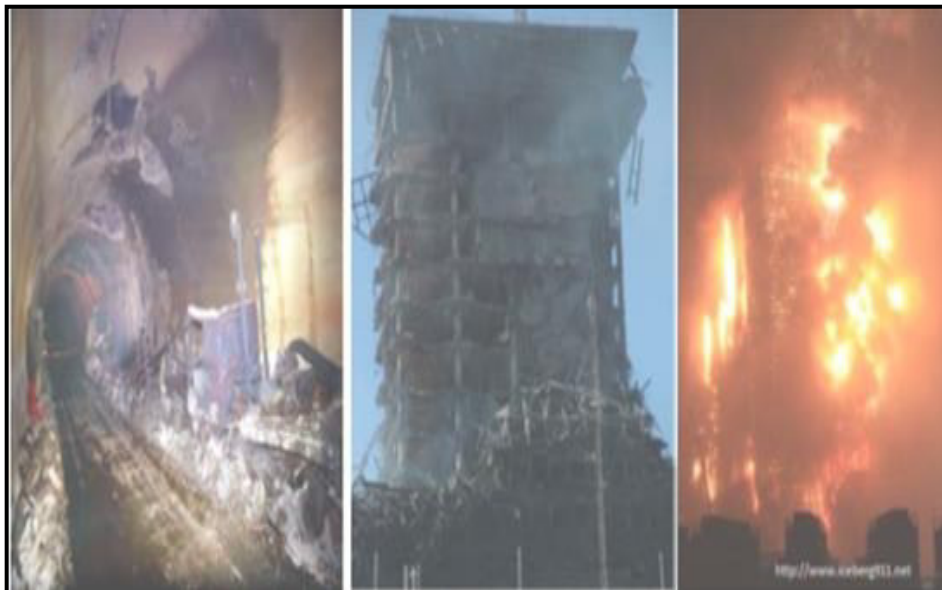
Fig. II. 3 Dégradation d'ouvrage s'en béton suite à un incendie [34].
