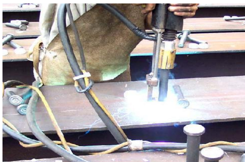
Fig.2.16 – Soudure des connecteurs goujons à tête.[10]
