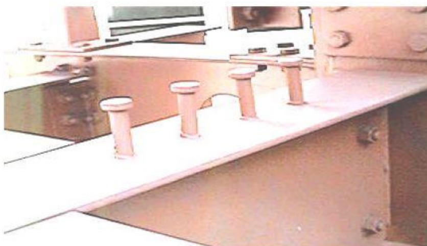
Fig.2.17 – Résultat final de la mise en place des goujons à tête.
