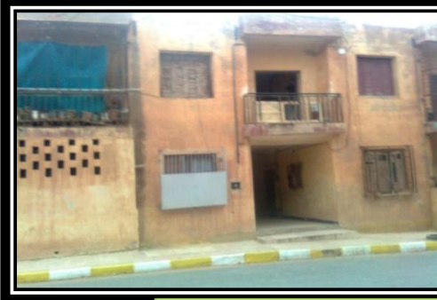
الصورة 36: عمارات قديمة.
