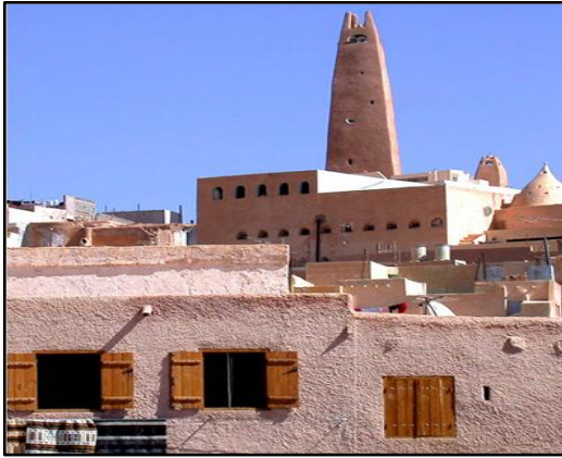
الصورة رقم (46): ارتفاع المسجد عن البنايات. المصدر: OPVM ، غرداية، 2006.
