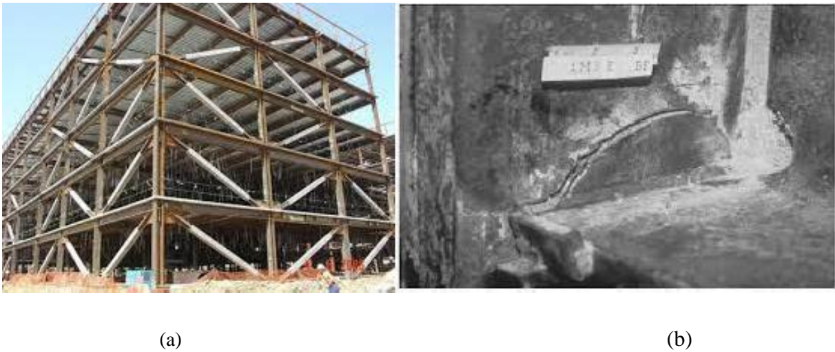
Fig.1.4. a) Structure en acier, b) Rupture de l'assemblage en soudure lors du séisme de Northridge 1994 [6].
