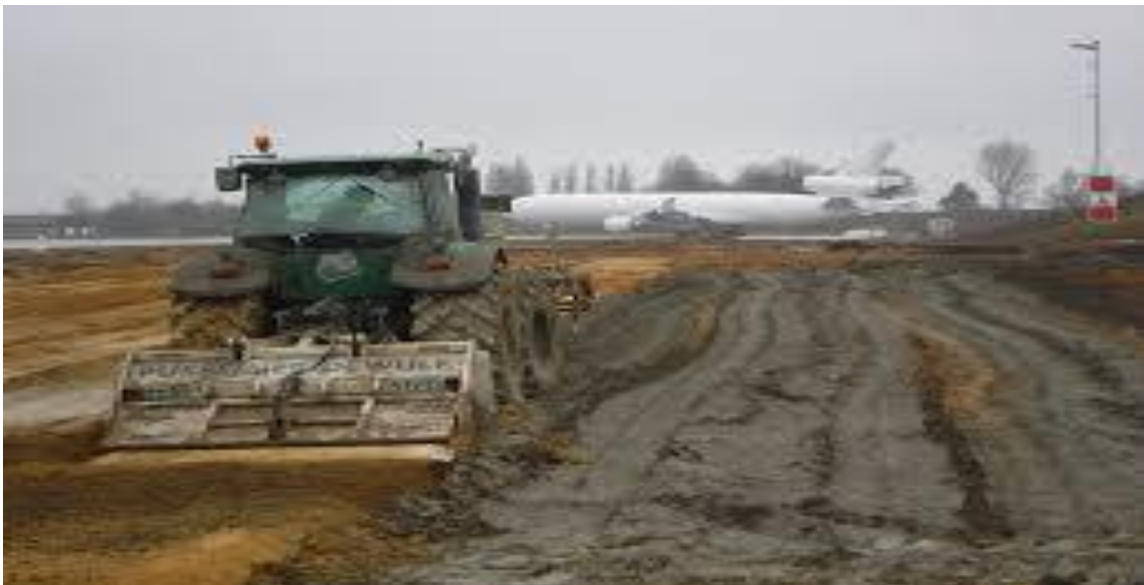
Figure I-13: Traitement des sols au Ciment
