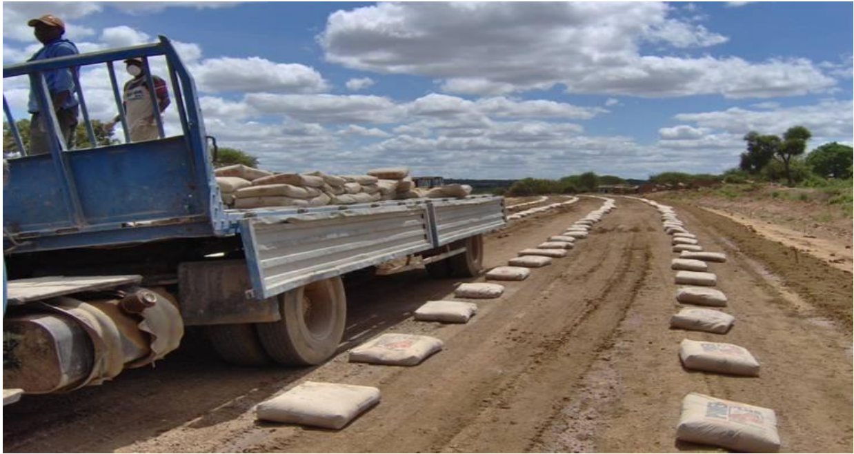
Figure I-18: Procédé classique d'épandage du ciment.
