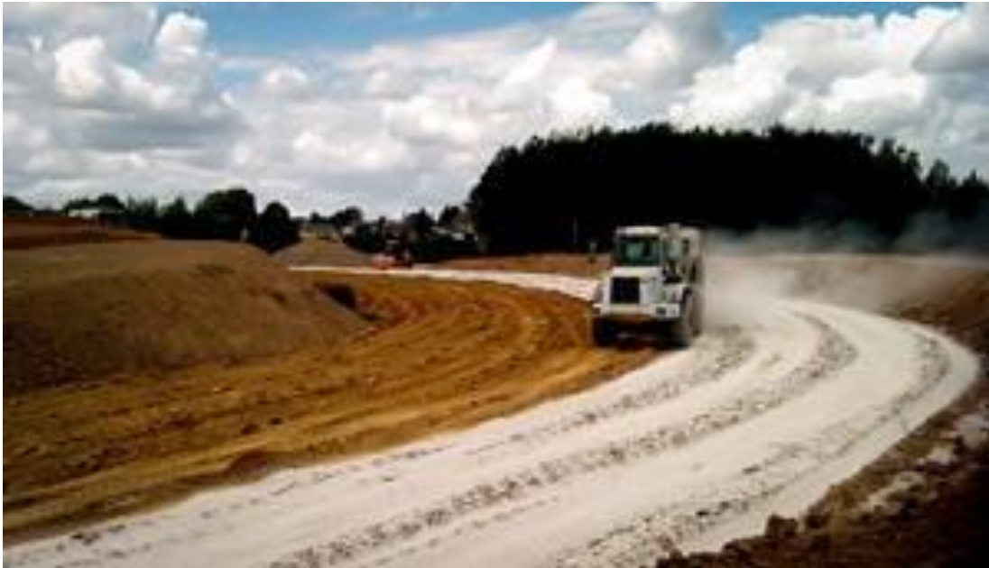
Figure I-15: Traitement des sols à la chaux
