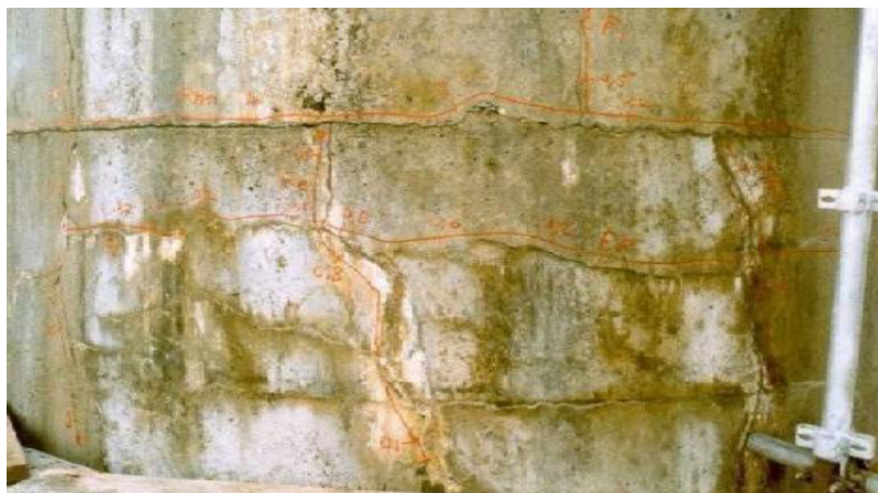
Figure. II.4: Attaque sulfatique interne
