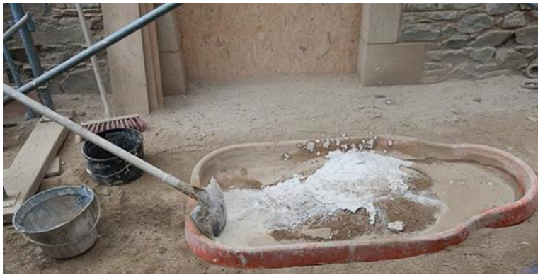
Figure.I.3 : La pâte de Mortier de chaux hydrauliques
