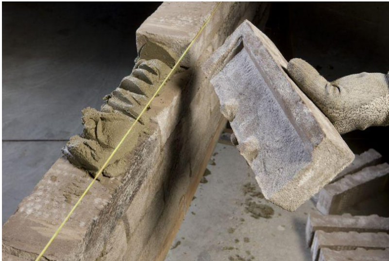
Figure.I.4 : Les joints de maçonnerie
