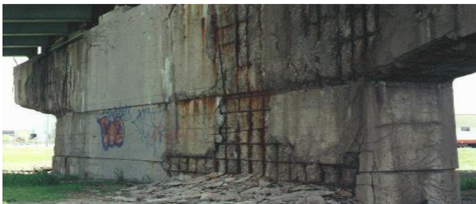
Figure.II.6 : agression du béton par activité des chlorures.
