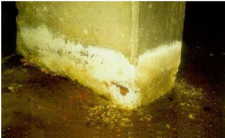
Figure. II.2: Attaque sulfatique externe
