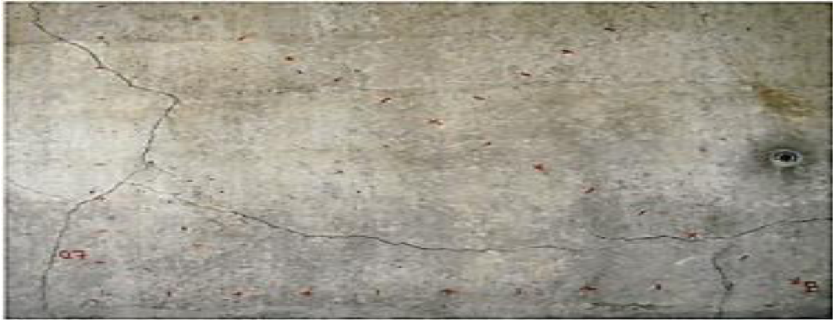
Figure. II.1: Des cas pathologiques d'éléments en mortier en contact de sulfate.
