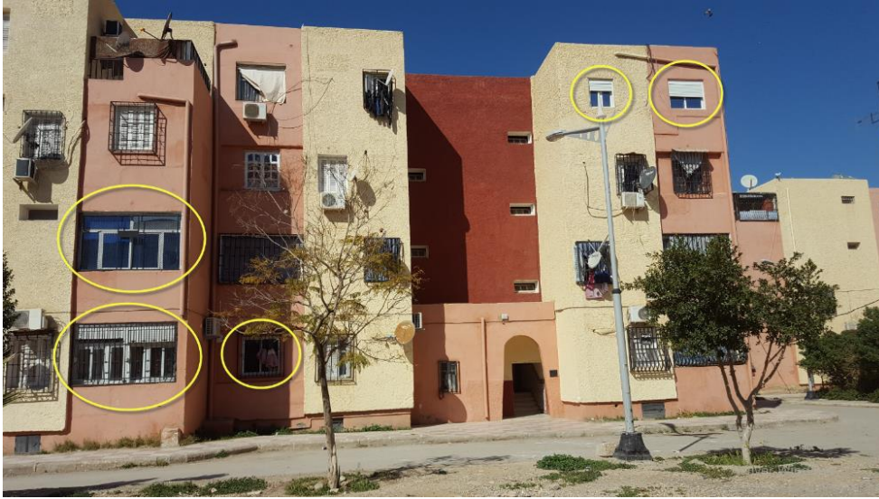
الصورة رقم (73): توضح استعمال النوافذ المنزلقة بإحدى عمارات منطقة الدراسة
