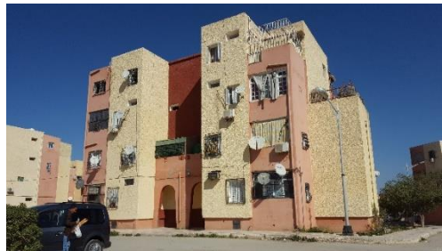
الصورة رقم 20: واجهة لإحدى عمارات منطقة الدراسة
