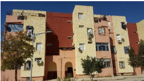
الصورة رقم 21: واجهة لإحدى عمارات منطقة الدراسة
