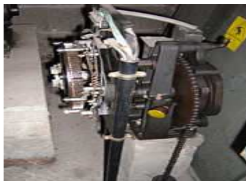
Figure II-6 : Limiteur de vitesse.
