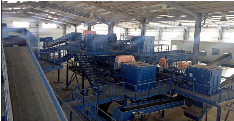
Figure. II.15 : Centre de tri des déchets de la ville nouvelle de Hassi Messaoud -Ouargla.[67]
