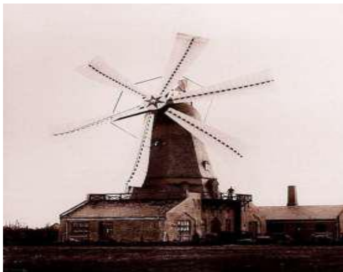
Fig. II-3: Éolienne de Poule La Cour
