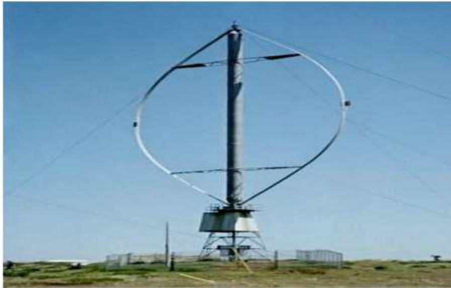
Fig. II-4: Éolienne de Darrieus
