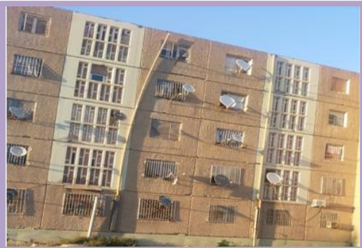
صورة رقم 20: واجهة الخلفية لعمارة قبل التدخل
