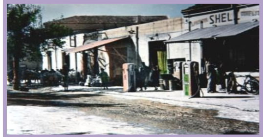
صورة رقم 08 : توضح محطة بنزين بالمدينة
