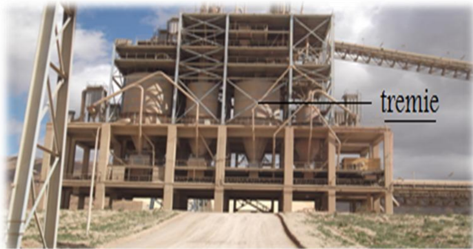
Figure (I.6) : Pré-homogénéisation.
