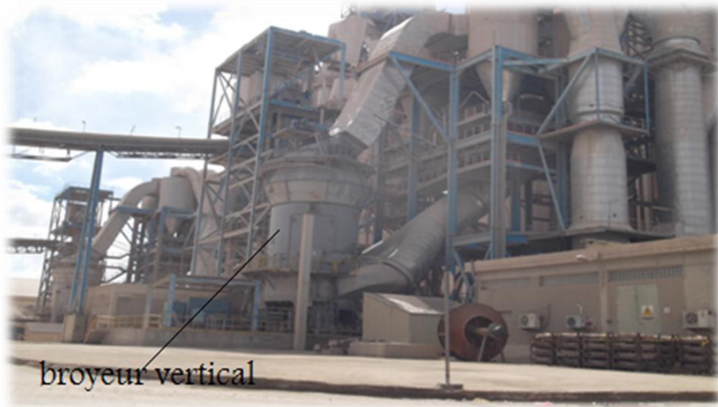
Figure (I.7) : Broyage cru (vertical).
