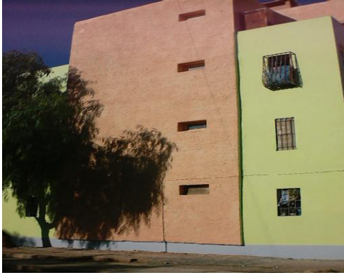
الصورة رقم 83 : الإطار المبني بعد التدخل
