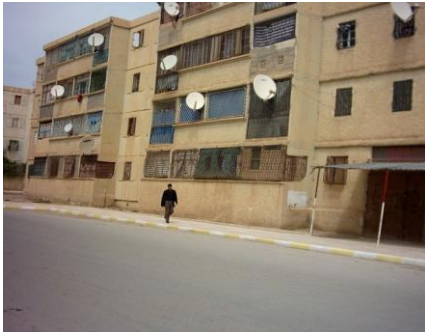
الصورة رقم 38 : تركيب الواقي الحديدي بالشرفات
