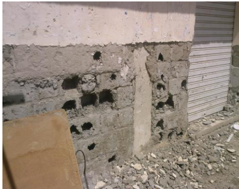
الصورة رقم 97 : التلبس الخارجي بالاسمنت نوع تيروليان مع النقر ونزع التلبس القديم والتنظيف الجيد بطبقتين على سمك متغير والرش بالآلة اليدوية وجميع المستلزمات
