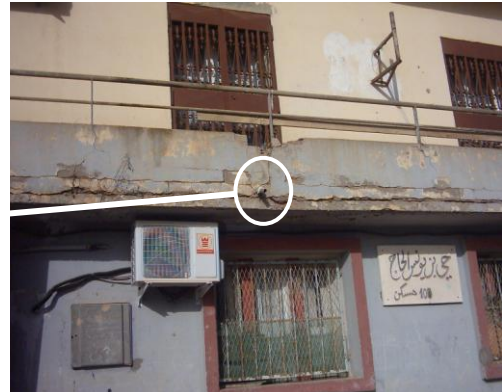
الصورة رقم 91 : التشققات على مستوى جدار الشرفات
