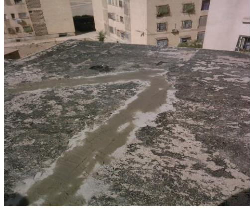
الصورة رقم 93 : نزع التغطية القديمة بالبلكس ألمنيوم مع التنظيف الجيد
