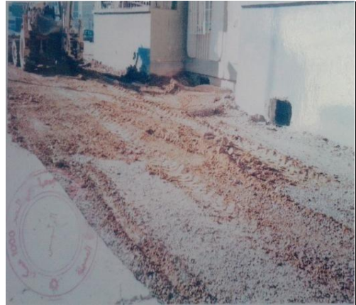
الصورة رقم 77 إعادة التهيئة تاريخ الصورة: 2002/04/11
