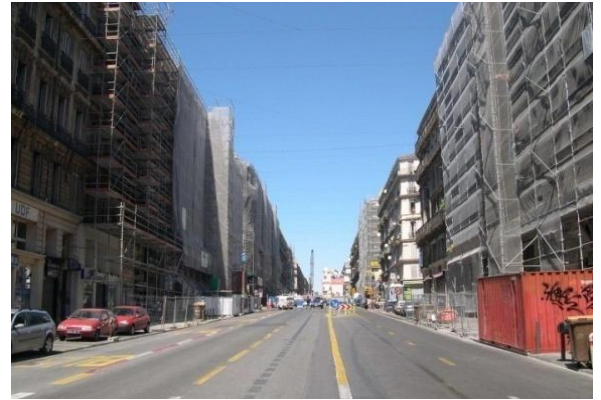
الصورة رقم 31 : إعادة ترميم الواجهات
