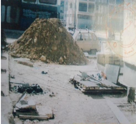
الصورة رقم 78 تجديد قنوات الصرف الصحي تاريخ الصورة: 2002/04/04
