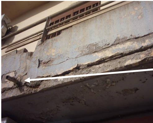
الصورة رقم 91 : التشققات على مستوى جدار الشرفات
