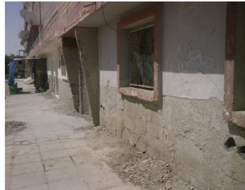
الصورة رقم 97 : التلبس الخارجي بالاسمنت نوع تيروليان مع النقر ونزع التلبس القديم والتنظيف الجيد بطبقتين على سمك متغير والرش بالآلة اليدوية وجميع المستلزمات
