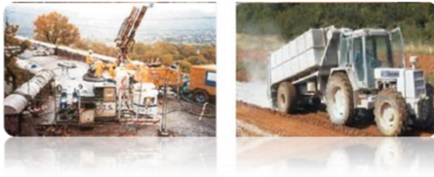
Fig. I.15: Traitement chimique à la chaux et au ciment.
