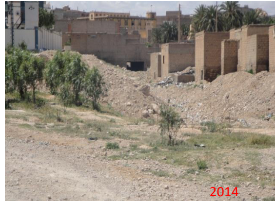
صورة (18.5): بناء سكنات وسط الواد
