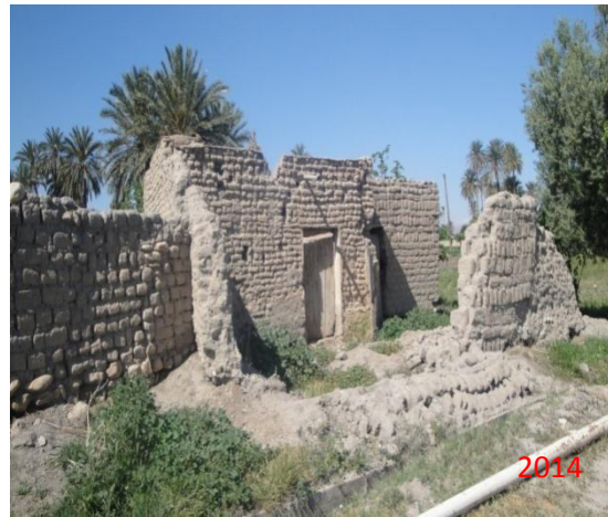
صورة (12.5): تهديم البنايات القديمة التي تمثل الموروث الثقافي للمنطقة
