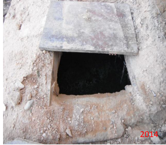
صورة (30.5): حفر لصرف المياه القذرة ما زال يستعملها السكان داخل منازلهم
