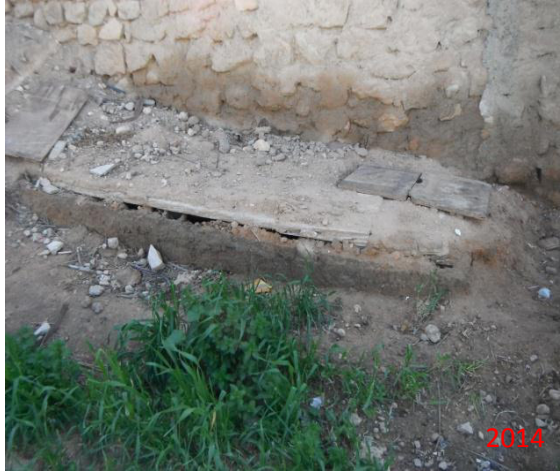
صورة (31.5): حفر لصرف المياه القذرة في فناء المنزل منازلهم
