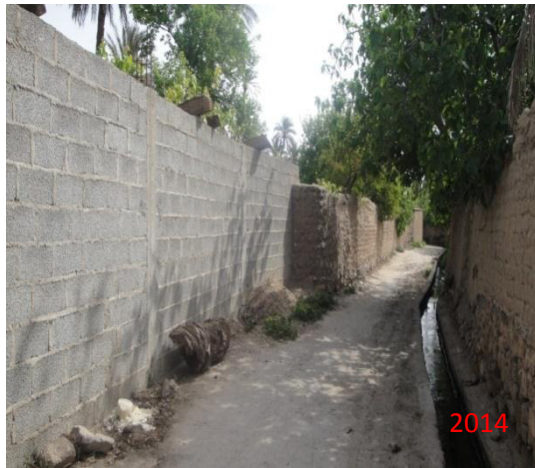
صورة (13.5): استبدال الحائط المبنى بالطوب بآخر بالاسمنت
