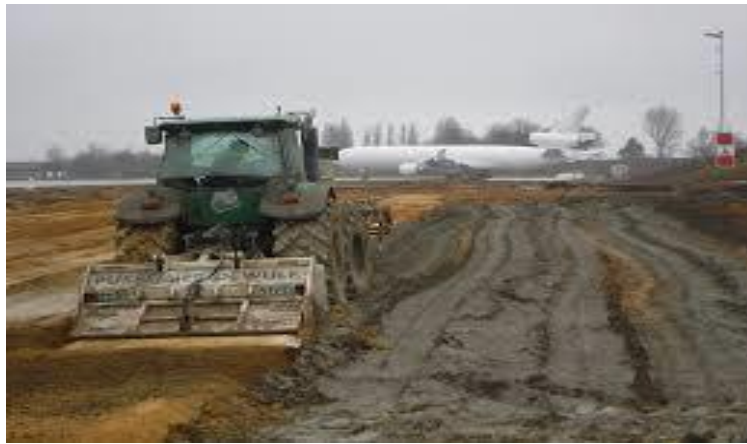
Figure I.4. Traitement des sols au Ciment
