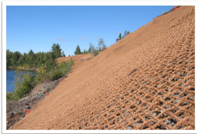
Figure II.1. Stabilisation avec fibres
