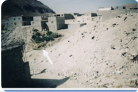
صورة رقم 08: عدم مراعاة طبوغرافية الأرض عند البناء
