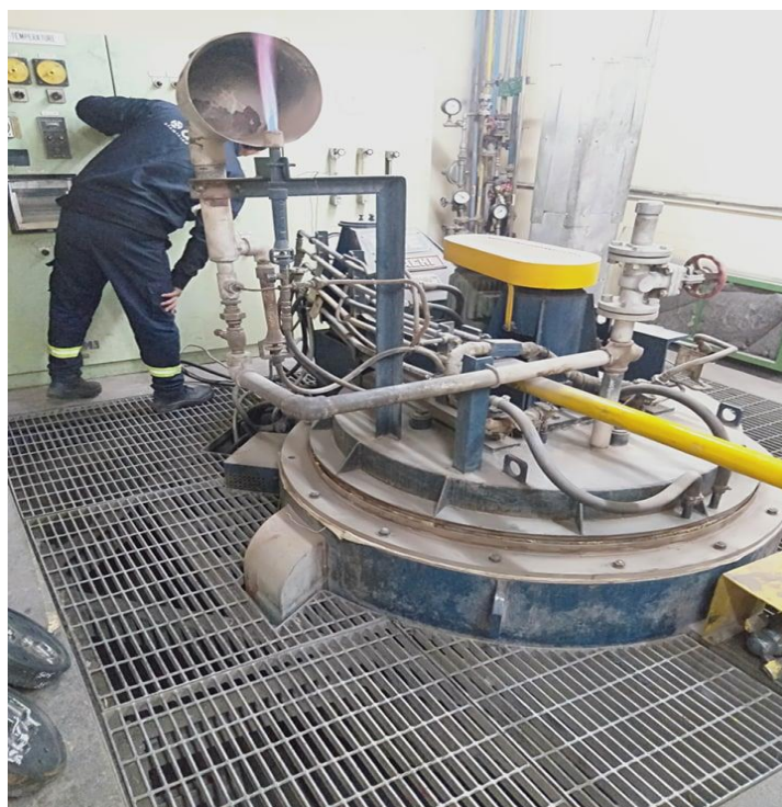
Figure.III.7. Four de nitruration « NACHI »
