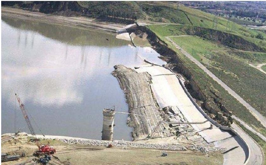
Fig. I.10 Rupture par liquéfaction [10]
