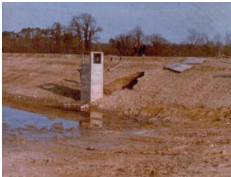
b- Débouché amont de renard sur conduite de vidange
