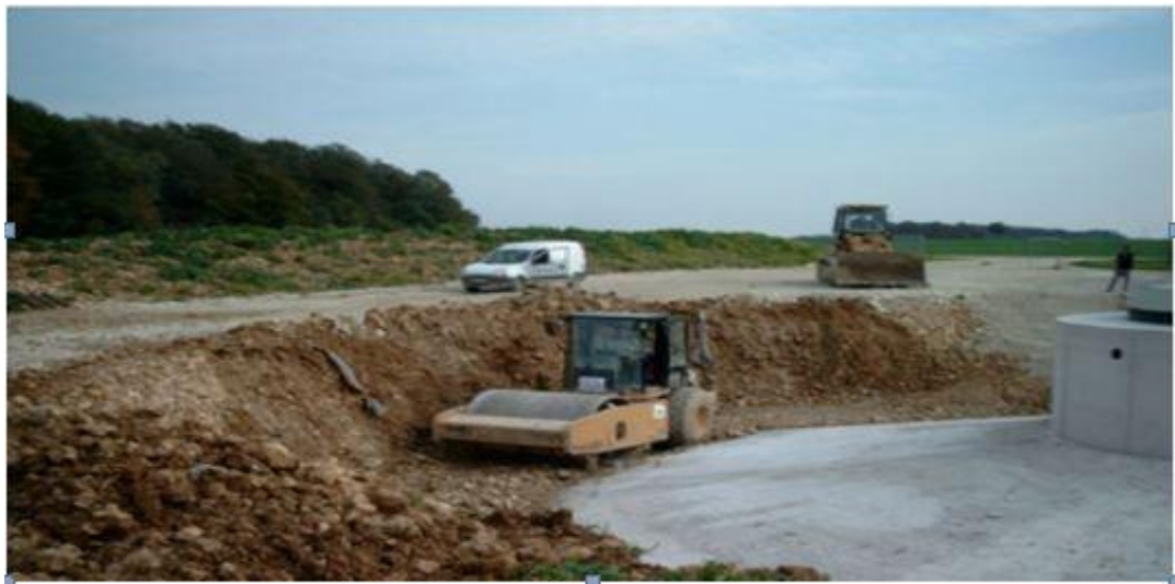
Figure 1.1 : Travaux de réalisation d'un remblai
