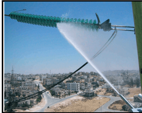
Figure I.9 Nettoyage des isolateurs
