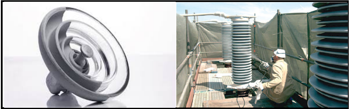
Figure I.8 Revêtement silicone d'isolateur
