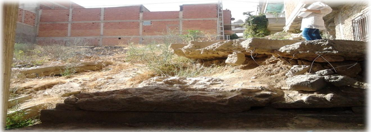
صورة رقم (16): انهيار سلالم وسط السكنات
