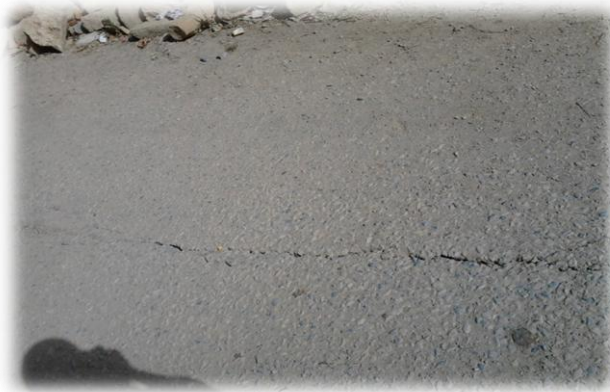
صورة رقم (14): ظهور تشققات في الطريق
