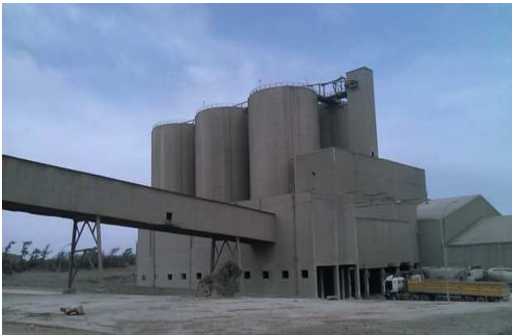
Figure I-10 : Silos de stockage de ciment.
