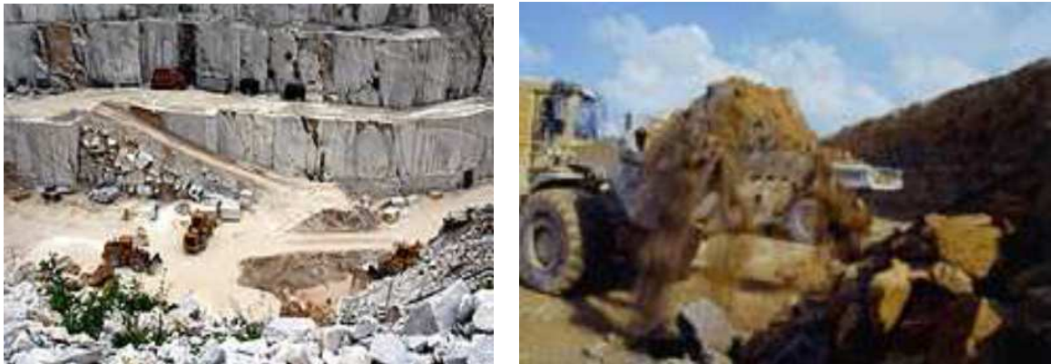
Figure I-3 : Carrière d'extraction de calcaire et d'argile.
