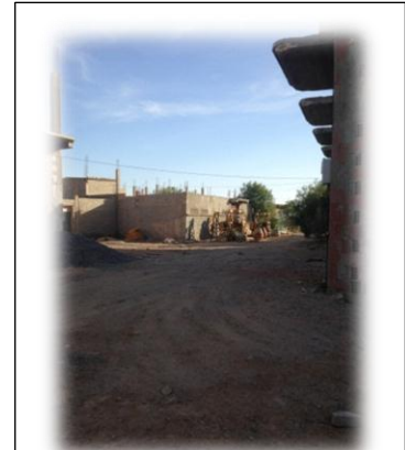
Figure N°31: rue 3em degré
