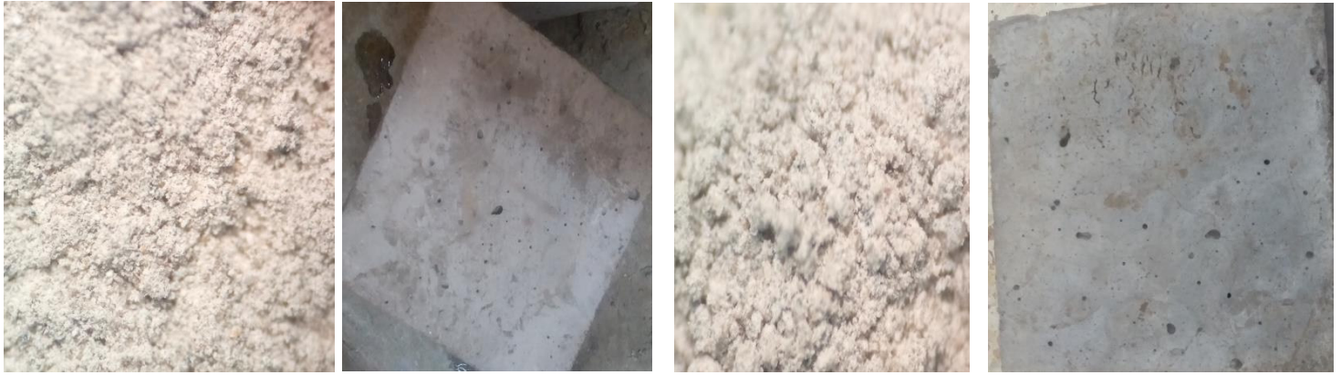
Figure IV.22 : Photographique et la surface de BF10 à 100° Figure IV.23 : Photographique la surface de BF10 à 300°
