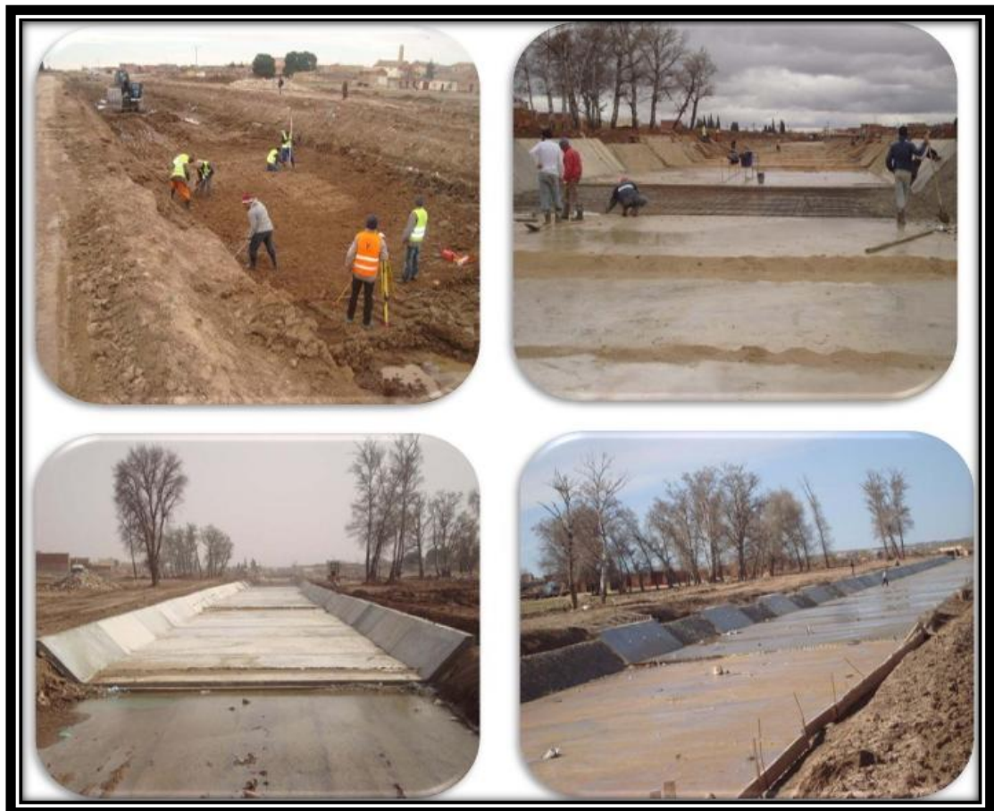
Photos n° 09 : Réalisation d'un canal Trapézoïdal
