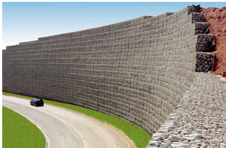
Figure 1.1- Mur de soutènement en gabion
