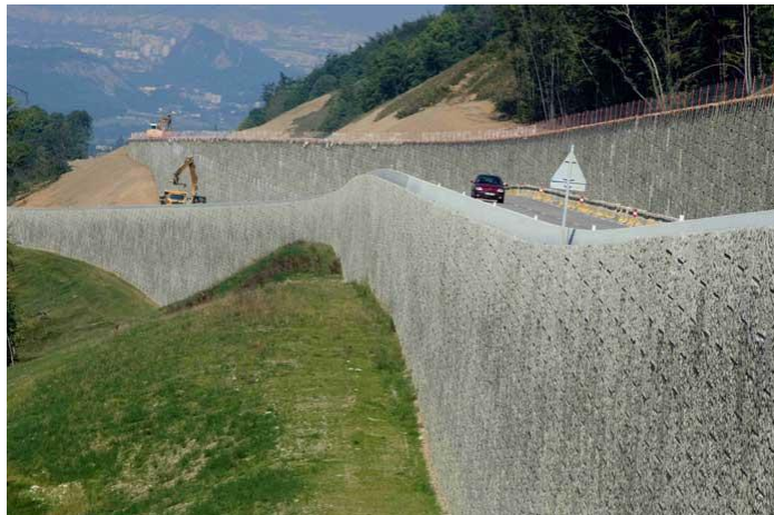
Figure 1.2- Mur en terre armée
