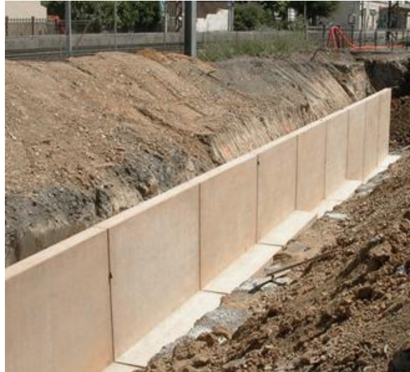
Figure 1.1- Mur de soutènement en béton armé
