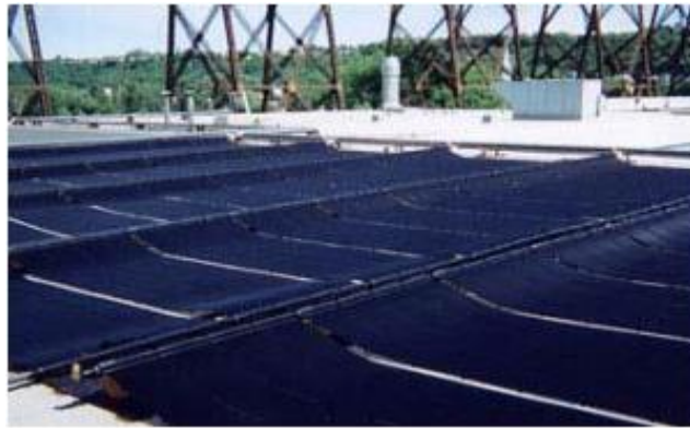
Figure (I. 2) : Capteurs plans sans vitrage[8]
