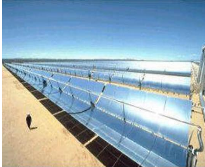
Figure (I. 5) : Système à réflecteur cylindro-parabolique
