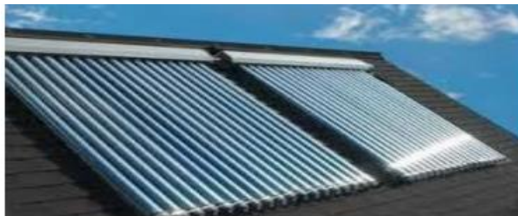
Figure (I.4) : Capteur sous vide
