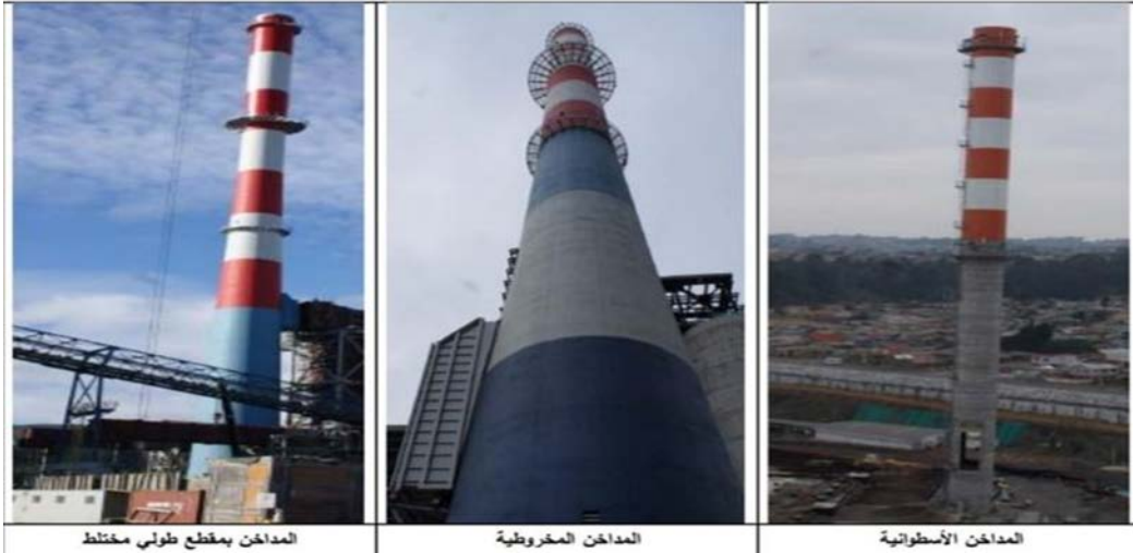
الشكل (1.8): أشكال المداخن في الواقع العملي [7]
