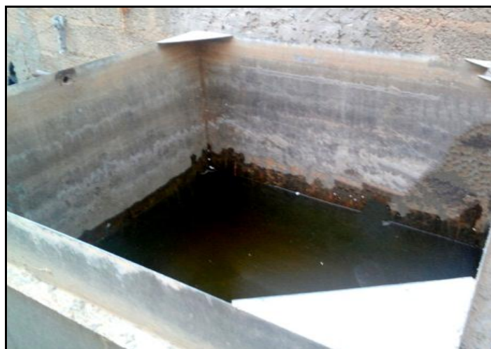
Figure2.10. Bassin (S2) (Source original).
