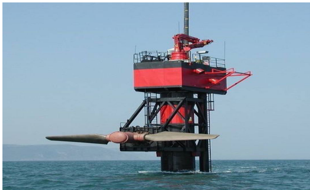
Figure I.3: Hydrolienne servant à capter les courants marins [7].
