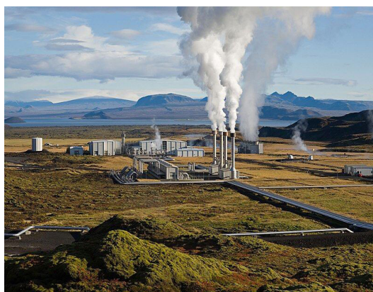
Figure I.7: Centrale géothermique en Islande
