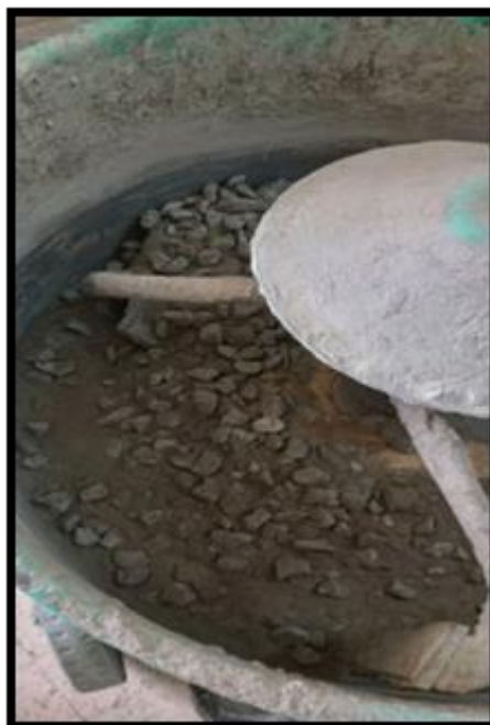
Figure III.6. Malaxage du béton ordinaire
