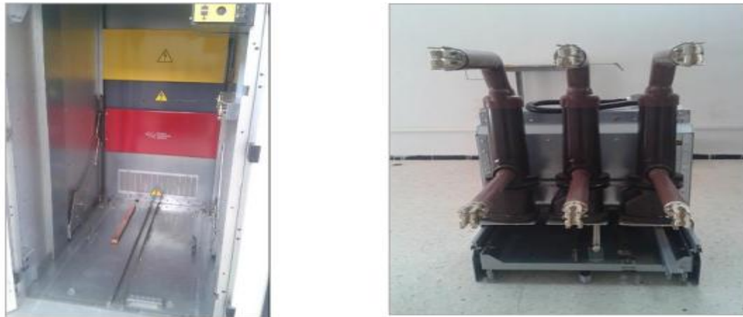
Figure.II. 3. Compartiment disjoncteur. [12]
